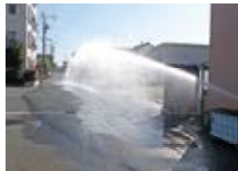
<VJ/WJの解体現場の防塵作業>
